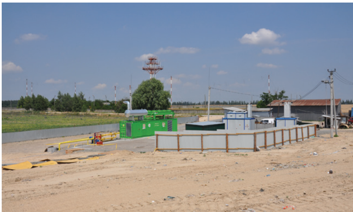
Рис. 3.8. Биогазовый двигатель GE Jenbacher мощностью 1063 кВт эл на полигоне г. Борисполь
