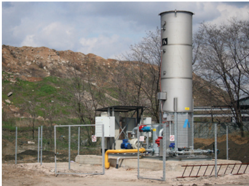
Рис. 3.6. Сбор и сжигание биогаза на факеле (Мариуполь, Донецкая область).
