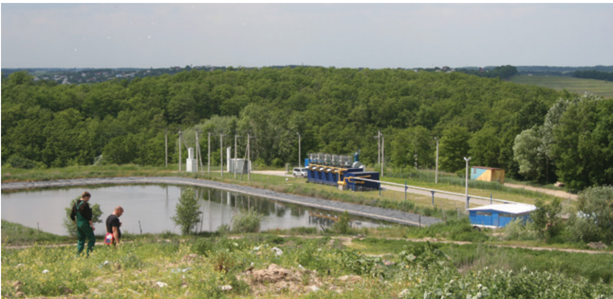
Рис. 3.7. Линейка биогазовых двигателей TEDOM мощностью 5x177 кВт эл на полигоне №5, Киевская область.
