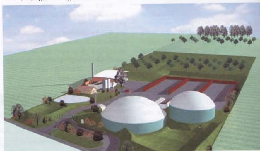
Рис. 2. Первая «биоэнергетическая деревня» в Германии (склады для хранения БМ, помещения для генерирующего оборудования, пруд-отстойник, силосные колонны)
