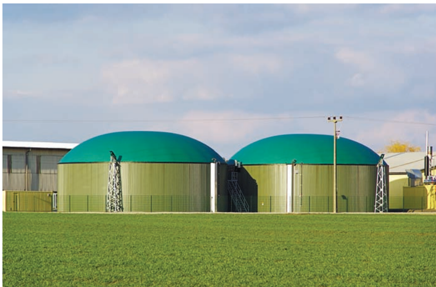
Малюнок 3-23: Типова система вертикального ферментатора на відходах сільського господарства
