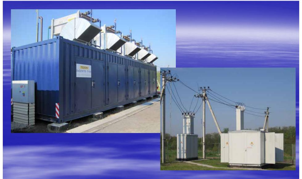
блок из 5 газопоршневих генераторов TEDOM Cento 180 (Чехия) и трансформаторной подстанции
