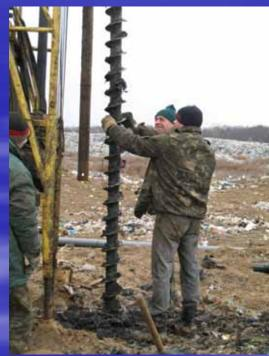
Коммерческая добыча БГС предполагает бурение скважин диаметром 500...1000 мм
