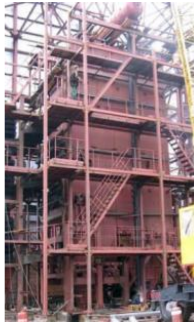
Котел компанії "Енергомашпроект"
