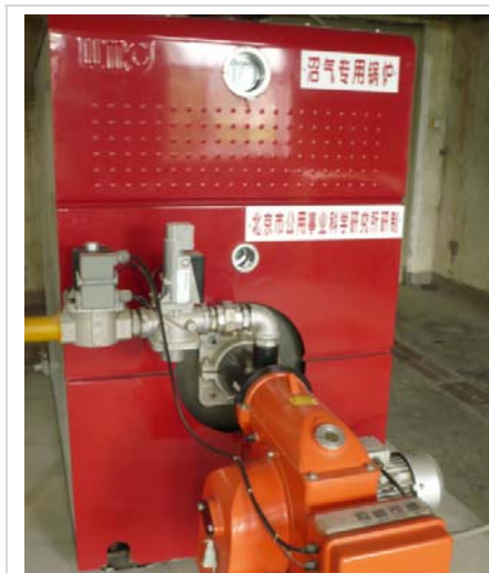
Рисунок 4-2. Водяной котел на полигоне Gaoantun в Пекине, Китай
