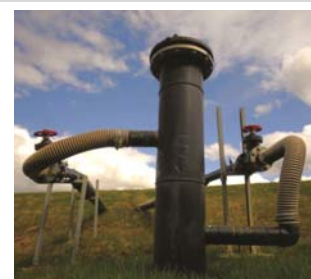
Рисунок 3-3. Оголовок скважины
