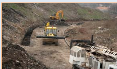
Монтаж трубопроводов
