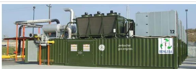
Рисунок 4-6. Двигатель внутреннего сгорания GE Jenbacher на полигоне Simprodeso в г. Монтеррей, Мексика
