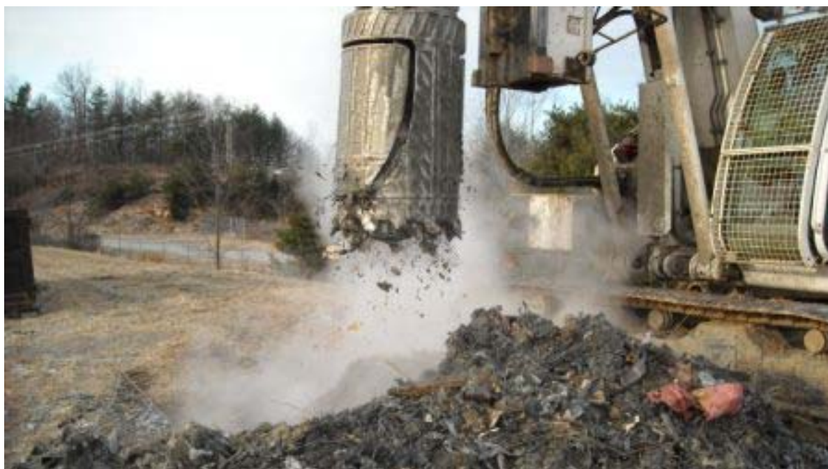
Рисунок 3-5. Бурение газосборной вертикальной скважины
