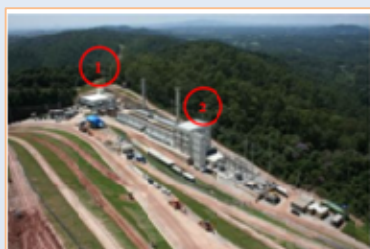
Станция дегазации (1) & энергетический блок (2)
