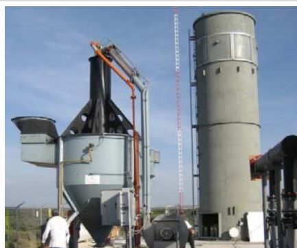
Рисунок 4-5. Испаритель фильтрата на полигоне El Verde в г. Леон, Мексика
