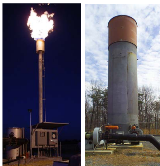
Рисунок 3-4. Открытый (слева) и закрытый факел (справа)
