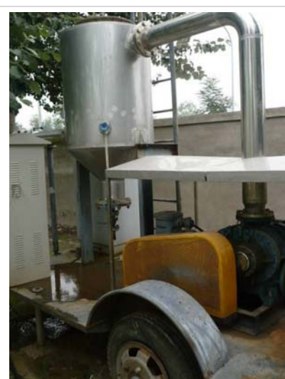
Рисунок 4-9. Отвод конденсата перед факелом на полигоне Gaoantun, Китай
