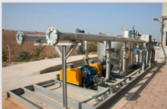
Оборудование на полигоне Jiaozishan
