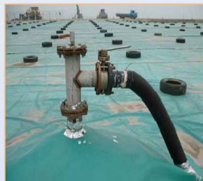
Типичная скважина на полигоне Gaoantun
