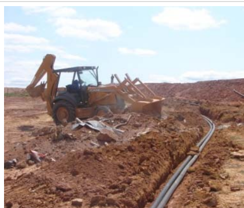
Рисунок 4-1. Монтаж трубопровода на полигоне Brazil MARCA в Кариасике, Бразилия
