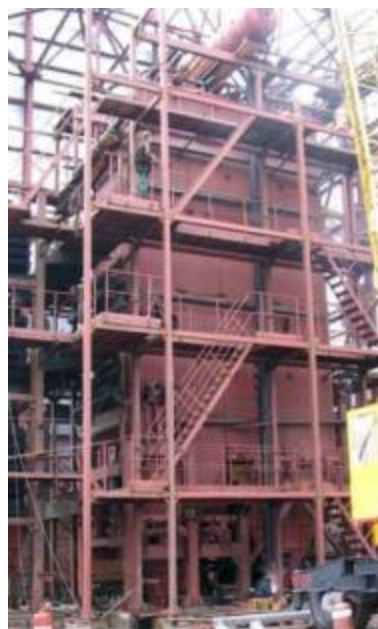
Котел компанії "Енергомашпроект"
