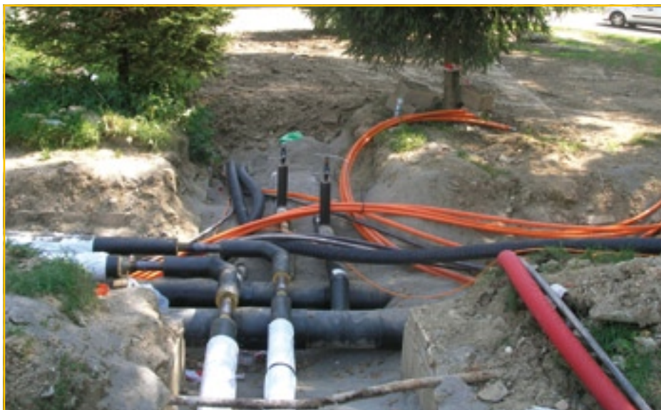
Заміна труб гарячого водопостачання в Гриньовій
