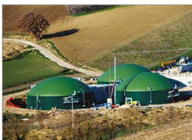
Мал. 14. Біогазова установка у Сан Патерніано (Італія). Використовує кукурудзяний силос 40 тонн та 40 тонн посліду на добу, 3 реактора х 2400 м 3 , ТЕЦ Jenbacher 999 кВт ел. Джерело: Zorg Biogas Group. 2014.
