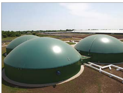
Мал. 15. Біогазова станція на фермі великої рогатої худоби на 6300 голів в с. В.Крупіль Київської області. Працює на гнойових стоках ферми – 300 тон на добу (вологість 95 %). Ферментатори 2400 м 3 х 3 шт., когенераційна теплоелектростанція Jenbacher 635 кВт ел та 662 кВт тепла. Джерело: Zorg Biogas Group. 2014.
