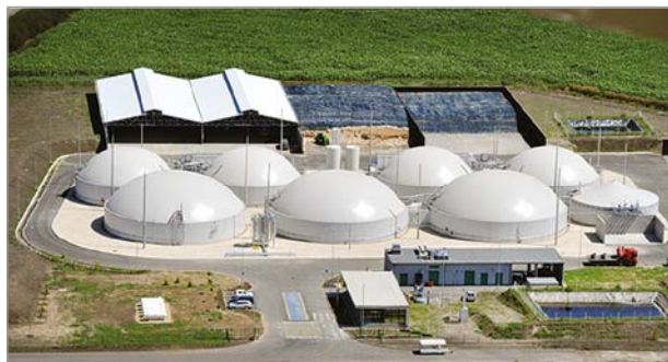
Мал. 12. Один з найновіших біогазових заводів в Угорщині, побудований німецькою компанією. Завод потужністю 4 МВт здатний переробляти до 90 000 т органічних відходів, включно з гноєм. Кількість енергії, яка виробляється на заводі, достатня для забезпечення електроенергією невеликого міста на 18000 мешканців 20 . Джерело: Renewable energy magazine, 2014.
