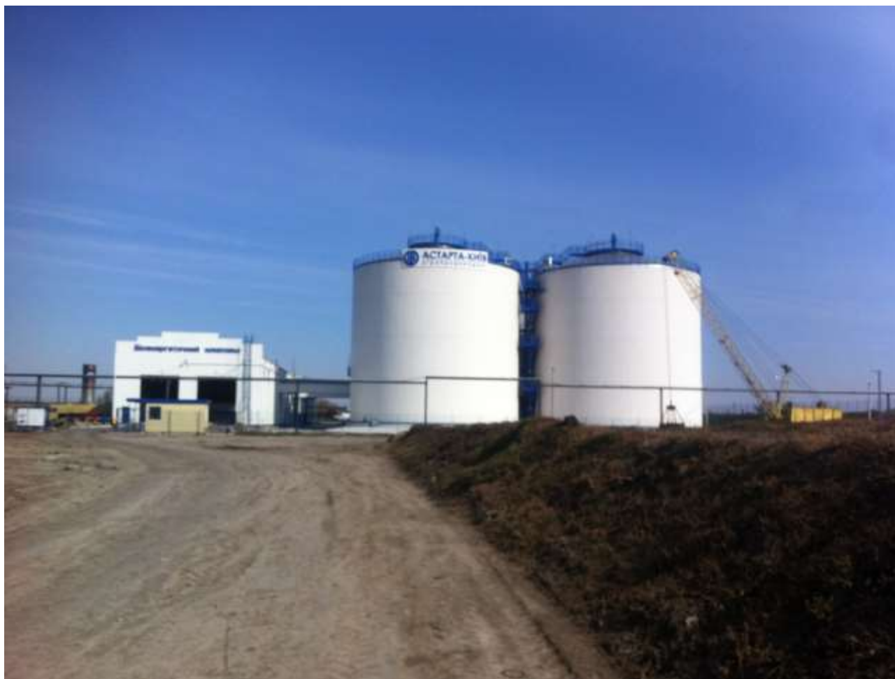
Глобинский сахарный завод
