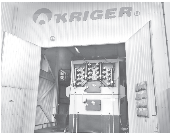
Фото 7. Котельня з твердопаливним котлом «Крігер»
