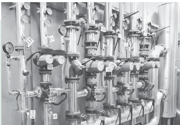
Фото 1. Котельня на базі котлів «Волинь-Кальвіс», що працює на пелеті з лушпиння соняшника
