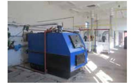
Рисунок 14 – Реконструкція котельні Мотовилівської ЗОСШ I-III ступенів із встановленням твердопаливного котла
