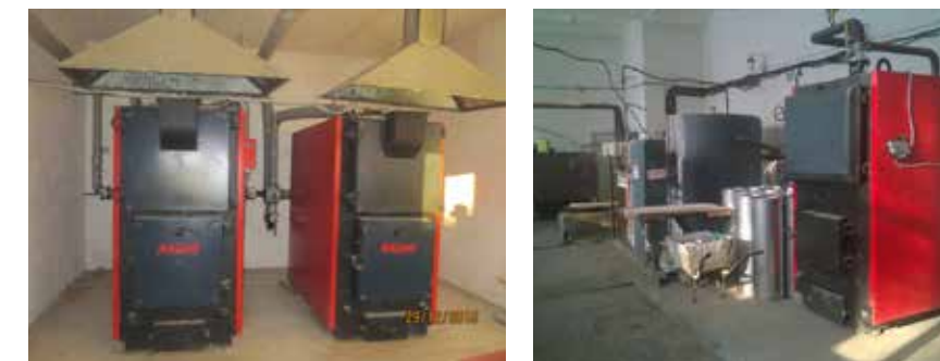
Рисунок 12 – Твердопаливні котли з ручним завантаженням палива
