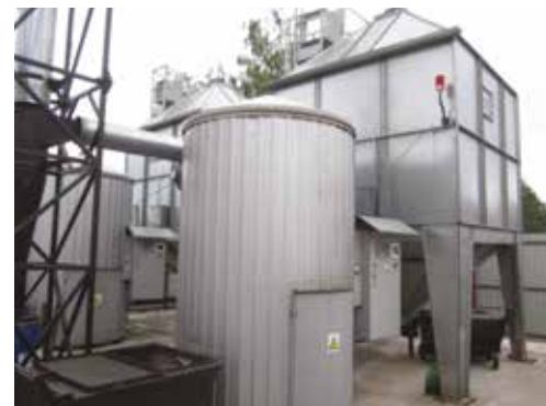
Рис. 18 – Модульна котельня відкритого типу з бункером для гранул із соломки в м. Житомир
