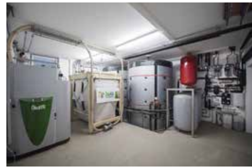
Рисунок 9 – Котельня з котлом на гранулах, бункером палива та з баками-акумуляторами 12
