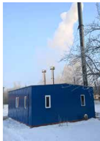
Рисунок 24 – Блочно-модульна котельня ЗОШ І-ІІІ ст. у с. Жадове, Чернігівська обл.
