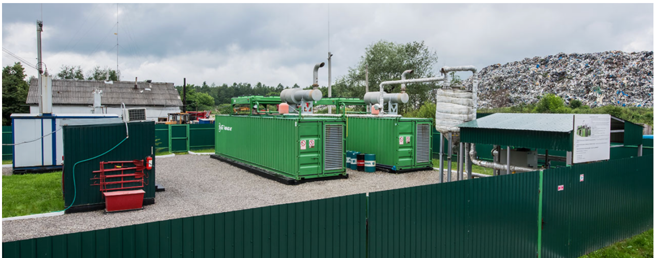
Рис. 4. Впроваджена електростанція потужністю 600 кВт на біогазі зі звалищ ТПВ в м. Івано-Франківськ.
