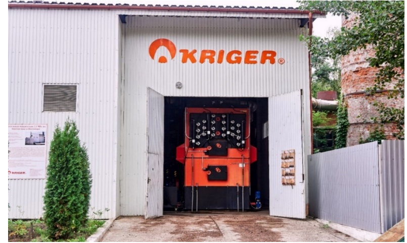
Котельня для спалювання деревної тріски потужністю 2 МВт
