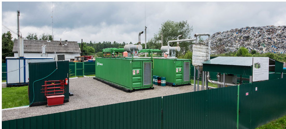
Івано-Франківська електростанція потужністю 660 кВт ел. на біогазі з полігону ТПВ
