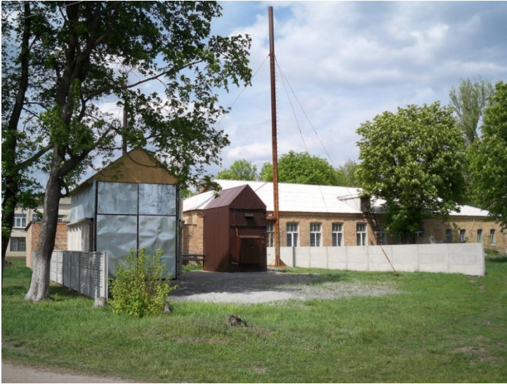
Теплогенератор ТС-350 встановлений для опалення школи в с. Стави Київської області
