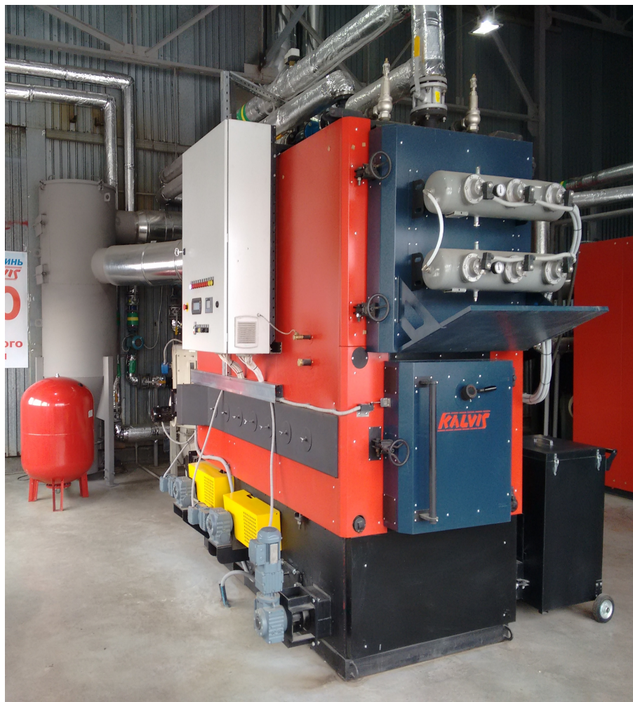
Промисловий котел «Волинь-Кальвіс» серії М-1 500 кВт
