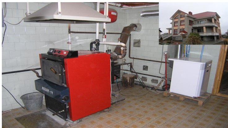
Побутовий котел потужністю 30 кВт
