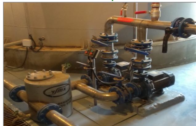
Механічний вловлювач і насоси бражки
