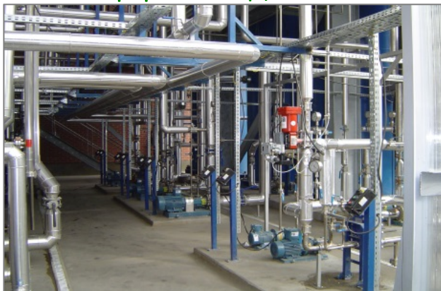
Нижня відмітка відділення ферментації, насосна
