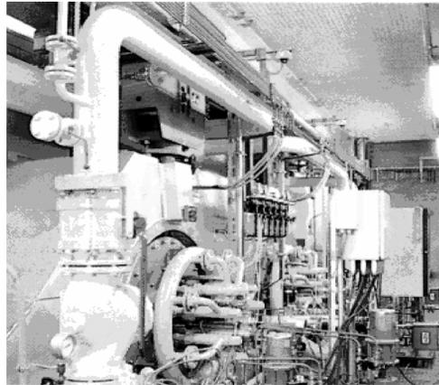
Рис. 2.11. Котел-утилизатор с дожиганием топлива в потоке уходящих газов двигателя [7].
