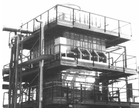
Рис. 1.30. Котел-утилизатор КУП 2700 с контактным конденсатором КК40.
