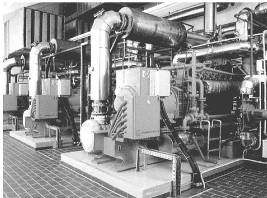
Когенерационная станция была сооружена в 1990 г. для энергоснабжения предместья г. Вердена. До этого времени в отопительной котельной ежегодно сжигалось 1,1 млн м<sup>3</sup> биогаза, полученных при очистке канализационных стоков. Проектом предусматривалось эффективное использование биогаза для комбинированной выработки электрической энергии и теплоты для обогрева метантенков и отопления жилых зданий.
