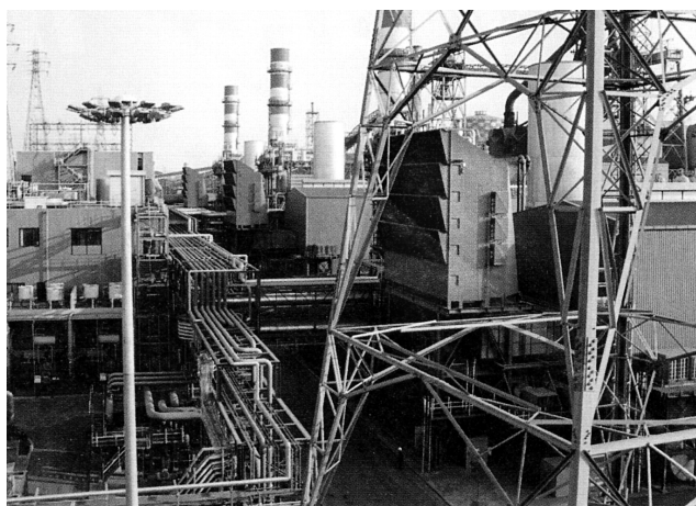
Общий вид ПГУ-ТЭЦ, работающей на смеси доменного, коксового и природного газа.
