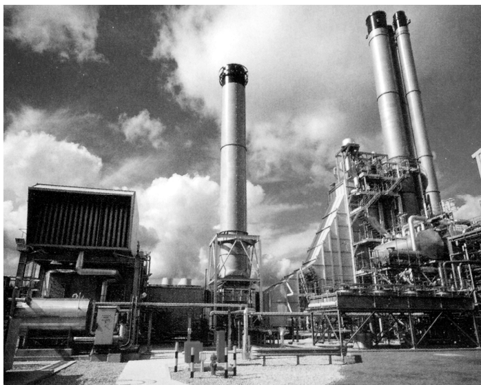
Промышленная ГТУ-ТЭЦ с горизонтальным котлом-утилизатором на основе ГТУ Trent-60 мощностью 58 МВт фирмы Rolls-Royce на комбинате по производству бумаги Bridgewater (Англия).
