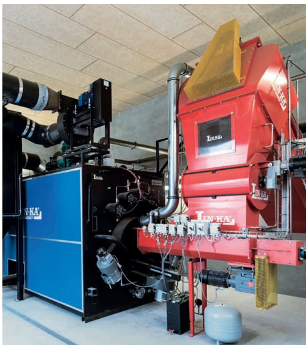
Установка з автоматичною подачею потужністю 800 кВт від Linka Energy. СВІТЛИНА Linka Energy.
