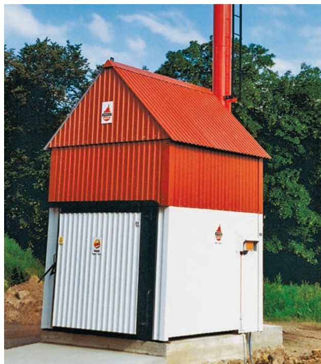
Установки періодичної дії часто встановлюють в окремій будівлі, щоб зменшити ризик пожежі. СВІТЛИНА Torben Skøtt, BioPress.
