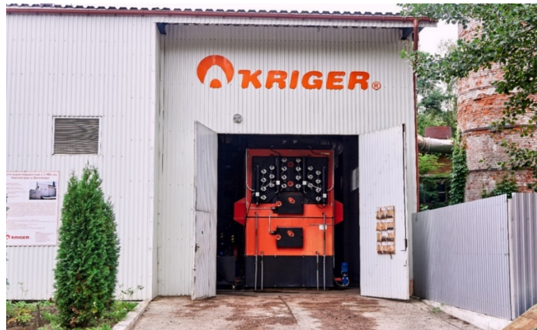
Котельня для спалювання деревної тріски потужністю 2 МВт
