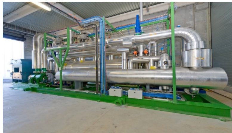
ТЕЦ 1,6 МВт ел на базі турбіни ORC в Кам'янці Подільському
