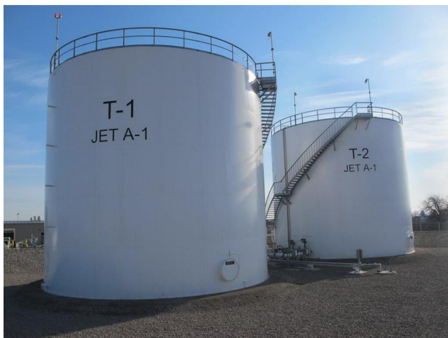
Рис. 2.5. Резервуари для зберігання реактивного палива Jet A-1 [45].
