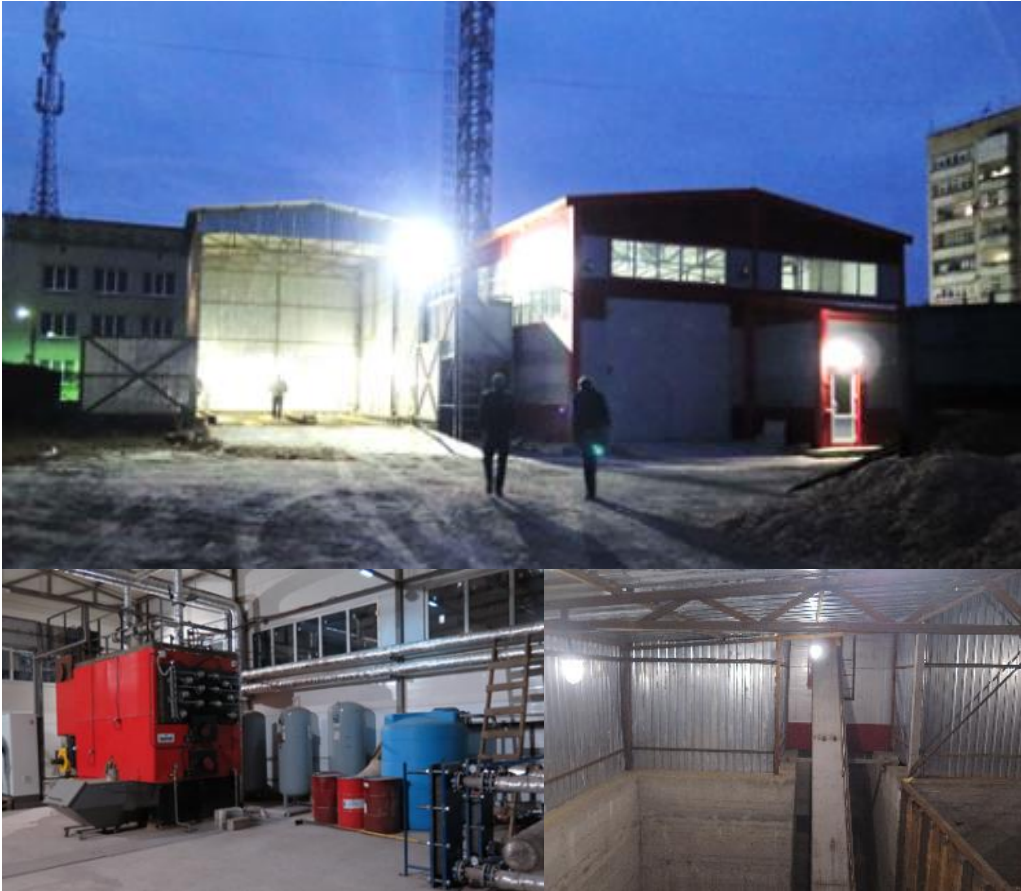
Місто Купянськ, 2016-2017 роки, котел Marten, 1 МВт (тріска) + котел на пелетах 0,6 МВт.
