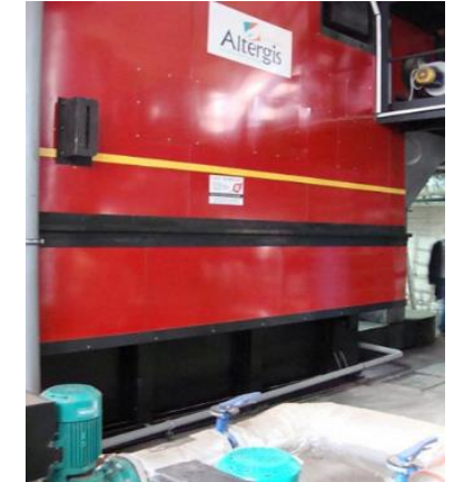
Черкаситеплокомуненерго, 2011 рік, 2,5 МВт, котел Комконт, паливо-деревна тріска, тирса, стрижні качанів кукурудзи
