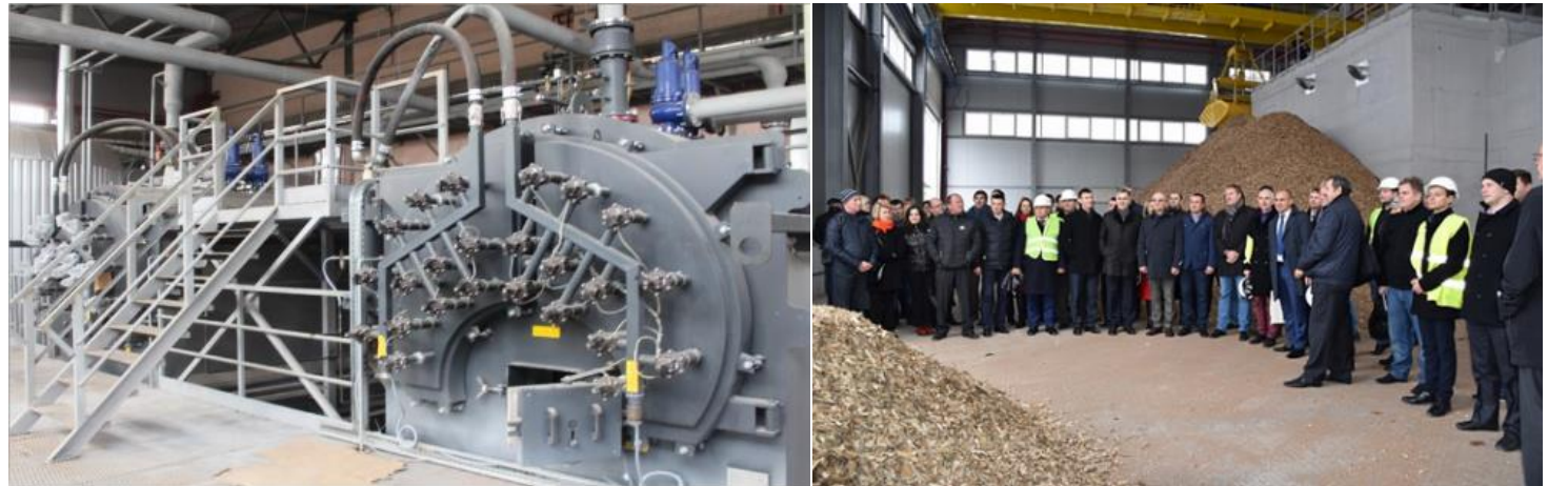
Вінницятеплоенерго, 2016-2017 рік, загальна потужність 5,2 МВт, два котли Mawera SFR 2600 по 2,6МВт, паливо- деревна тріска
