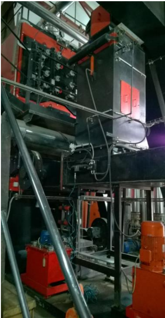
ТОВ «Камелія», 2014 рік – котельня на біомасі для опалення теплиць, 7 МВт. Встановлено 3 котли Крігер по 3,5 МВт. Паливо- тріска, пелети.
