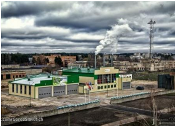
Місто Славутич, 2013 рік, 10,5 МВт, 3 котли Комконт, паливо-деревна тріска
