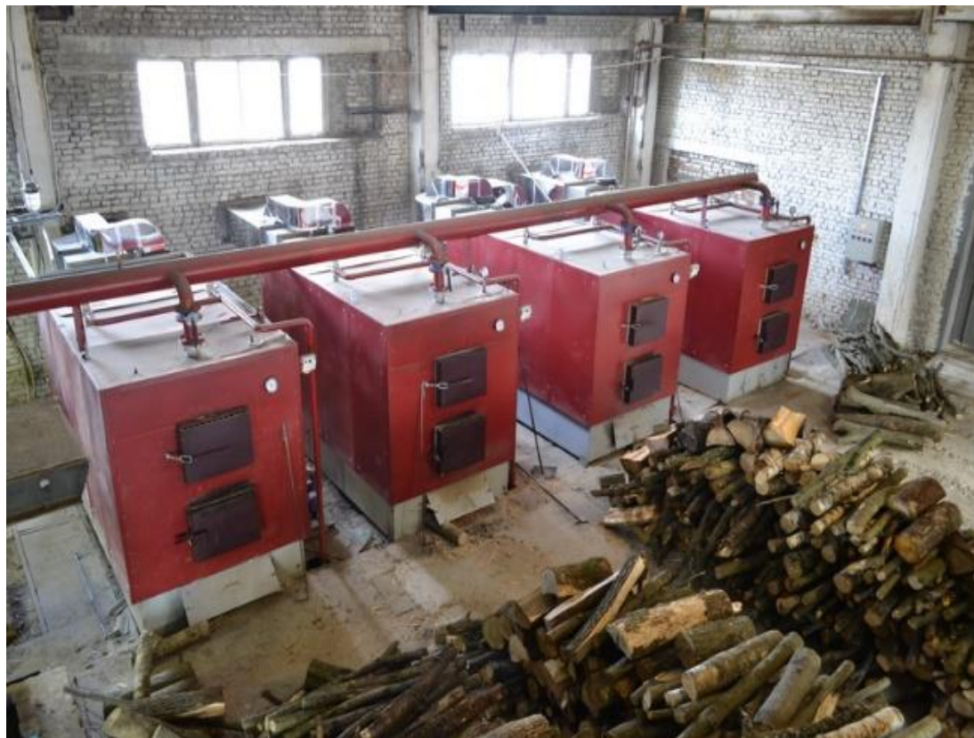
Котельня на дровах встановленою потужністю 4 МВт (реконструкція котельні військової частини, Львівська область)
