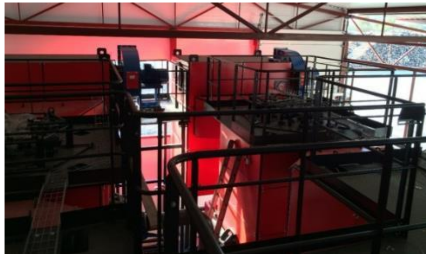
ТОВ «Камелія», 2014 рік – котельня на біомасі для опалення теплиць, 7 МВт. Встановлено 3 котли Крігер по 3,5 МВт. Паливо- тріска, пелети.
