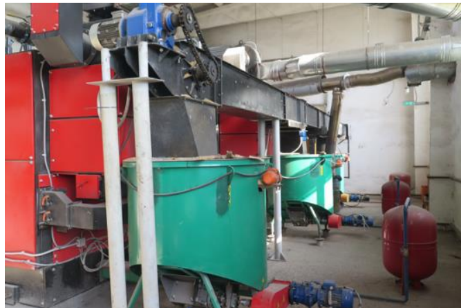
Жовкватеплоенерго, 2014-2016 роки, 4 МВт, 3 котли Крігер КВм-0,82 +котел Крігер GP 1,5 МВт
