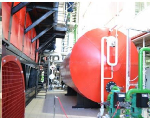
ТЕЦ в м. Кам'янець-Подільський, 1,8 МВт(ел)+40 МВт(т), котел Крігер на термоолії + модуль ORC (Франція). Паливо- деревна тріска.
