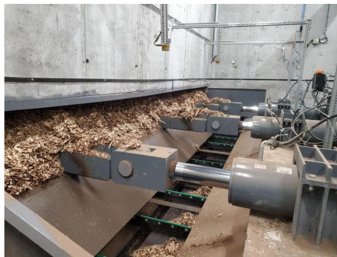
ТЕЦ на біомасі в м. Житомир, турбіна ORC 1,2 МВт(ел), 7,1 МВт (тепл.). Паливо -деревна тріска, відходи деревообробки
