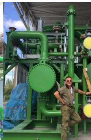
ТЕЦ в м. Кам'янець-Подільський, 1,8 МВт(ел)+40 МВт(т), котел Крігер на термоолії + модуль ORC (Франція). Паливо- деревна тріска.
