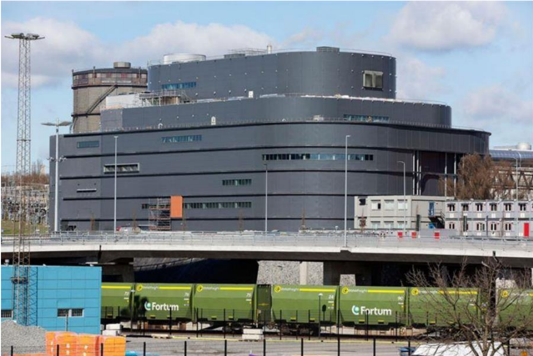
ТЕЦ Värtaverket в м. Стокгольм, Швеція. Встановлена потужність — 280 МВт(т) та 130 МВт(е)
