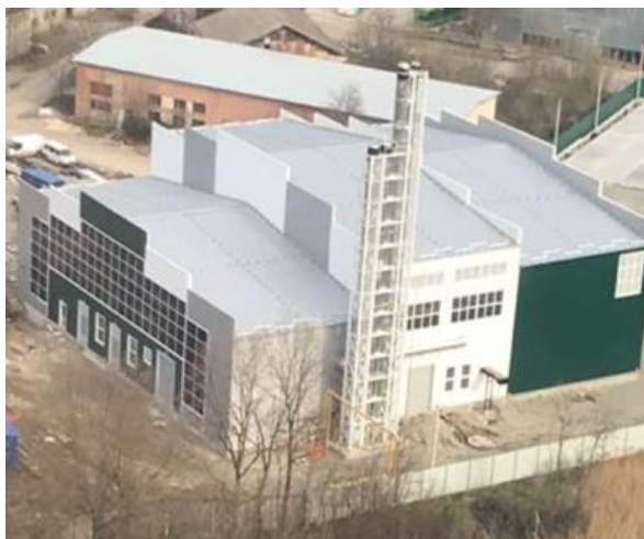
ТЕЦ в м. Кам'янець-Подільський, 1,8 МВт(ел)+40 МВт(т), котел Крігер на термоолії + модуль ORC (Франція). Паливо- деревна тріска.
