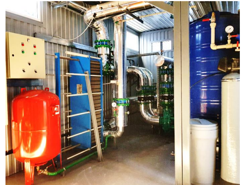
Водотрубний водо- водяний теплообмінник
