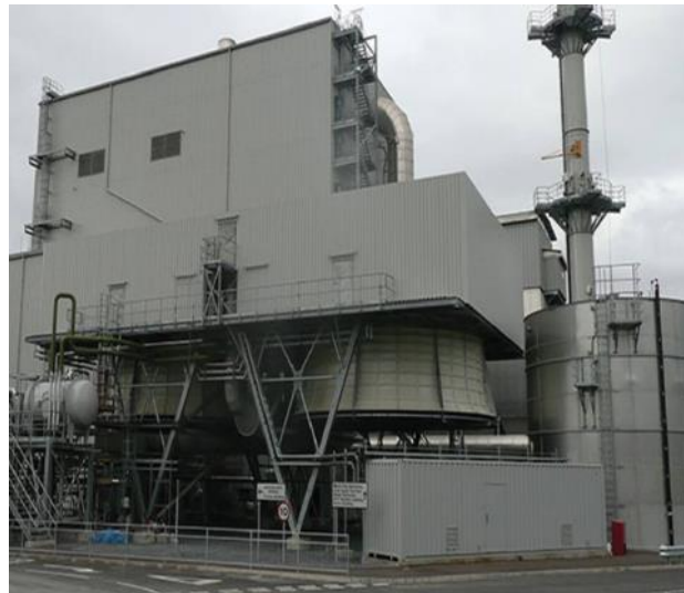
Повітряний конденсатор парової турбіни
