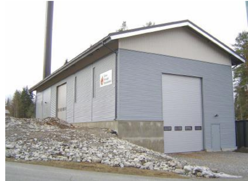
Котельня 2 МВт на деревних трісках кооперативу Eno Energia
