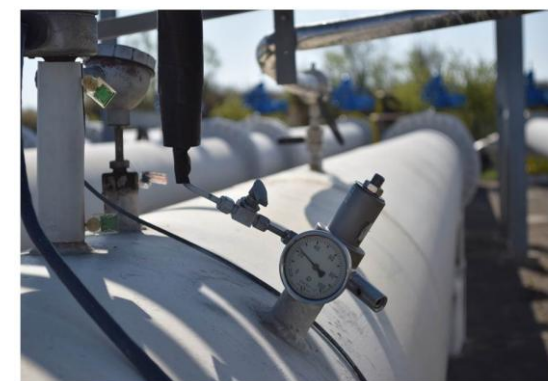
Пробовідбірний зонд на вимірювальному трубопроводі
