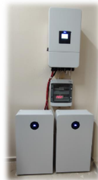
Лабораторія дообладнана піччю тривалого горіння та інвертором 12 кВт з 2*16 кВт батареями
