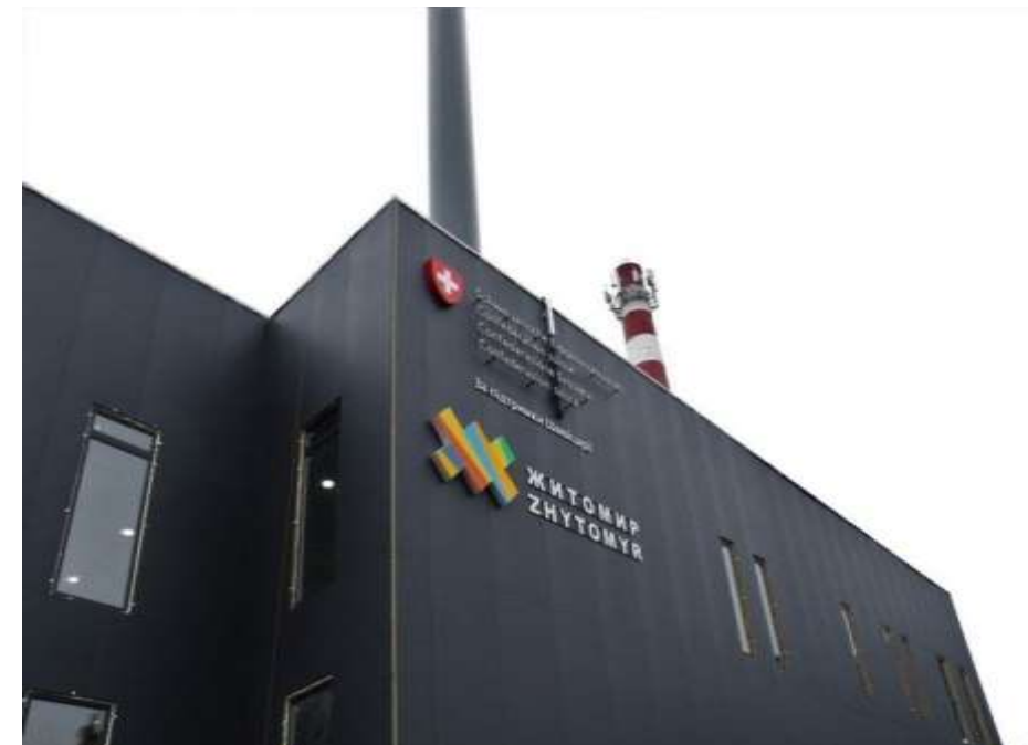
Модернізовані котельні та ІТП КП «Житомиртеплокомуненерго»
