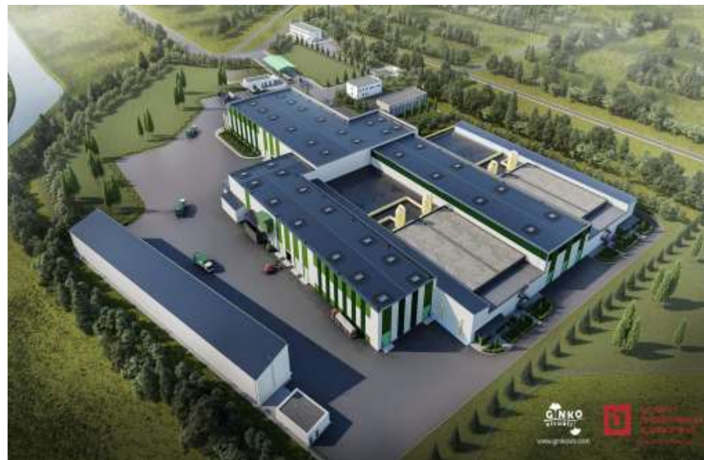
Будівництво комплексу МБО на вул. Пластовій, 13 (ЛКП «Зелене місто»)
